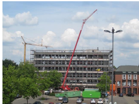
Sanierung des Rathauses Kevelaer, Wallfahrtsstadt Kevelaer
